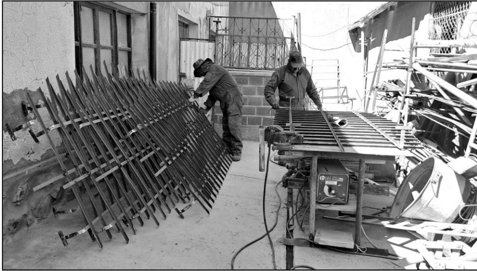
Le soudeur, M. Oscar, et son assistant renforcent les grilles dans l'atelier de la maison paroissiale.
